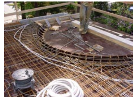
Deckenloch im Galeriebereich
