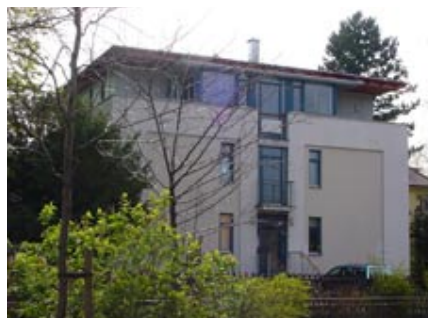
Fassade Treppenhaus und Eingang
