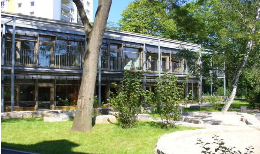
Südliche Außenansicht mit Fluchtbalkon
