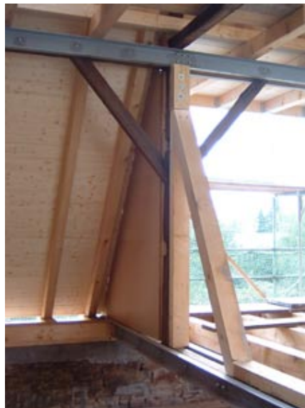
neue Sparrenlage mit altem Dachstuhl
