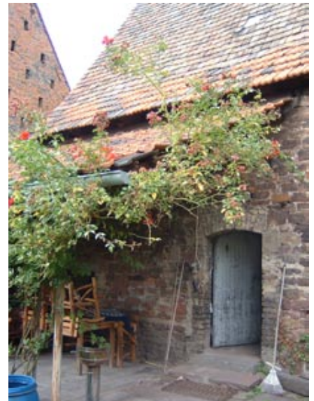
Eingang Tenne vom Garten
