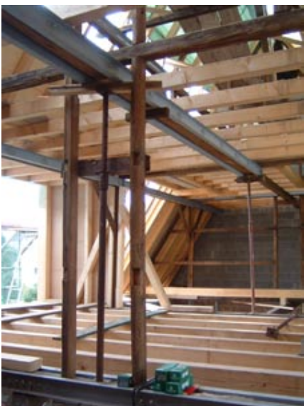
OG mit Pfettenverstärkungen
