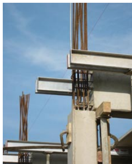
schneller Baufortschritt mit Halbfertigteilen
