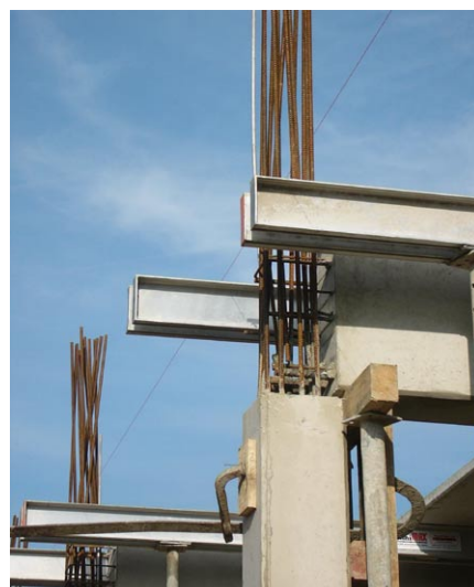
schneller Baufortschritt mit Halbfertigteilen
