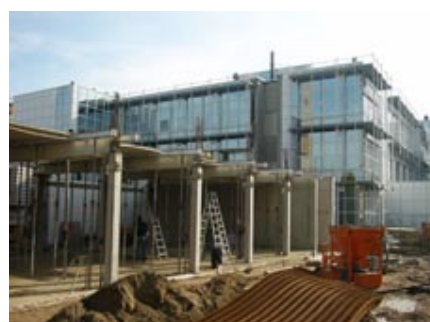
Stützen EG mit Halbfertigunterzügen
