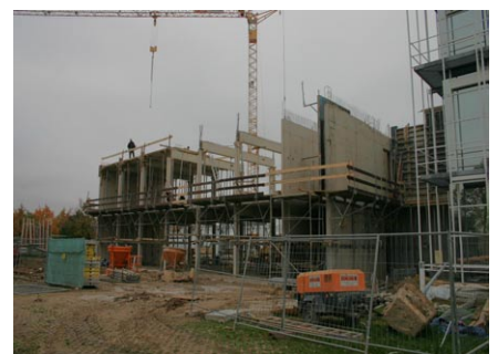
Decke über OG mit Halbfertigteilen
