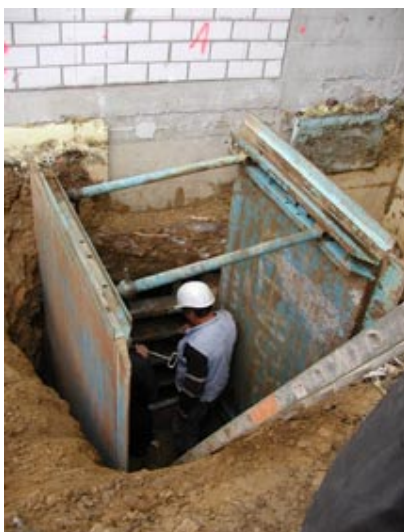
Unterfangung des Bestands
