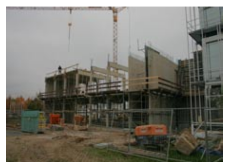
Decke über OG mit Halbfertigteilen
