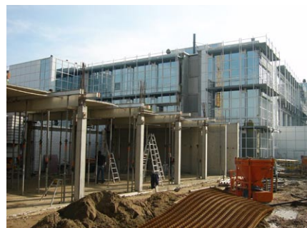
Stützen EG mit Halbfertigunterzügen
