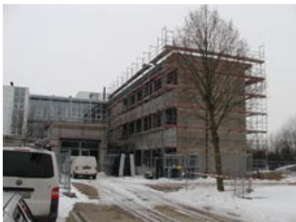
Rohbau fast fertig
