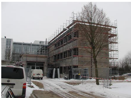
Rohbau fast fertig
