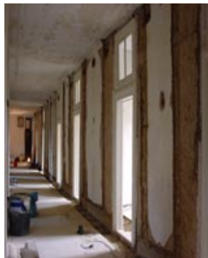
Aussparungen für die Stahlträger
