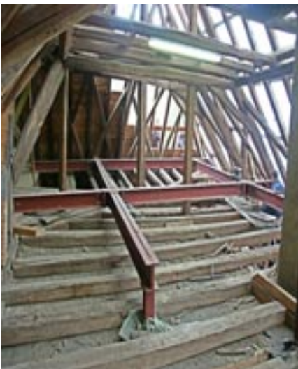
Stahlrost über der Prälatur
