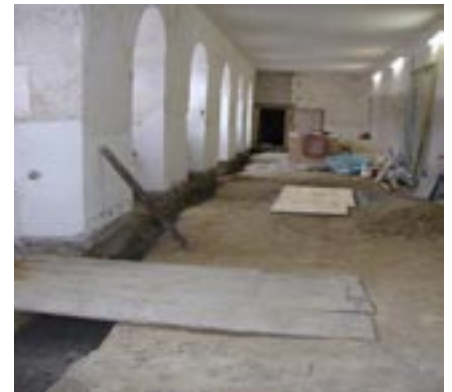
Wand im EG bekommt neues Fundament
