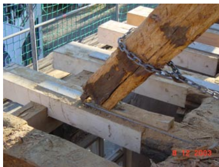
Aufschlagen des neuen Giebels
