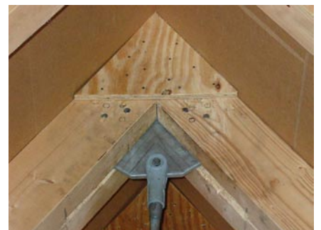
Detail Hängewerk
